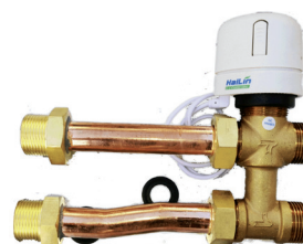
3-х ходовой клапан с узлом обвязки
